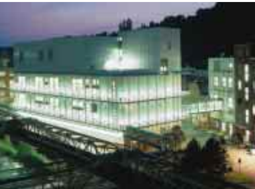
Das neue Pharma-Technikum in Wuppertal-Elberfeld
