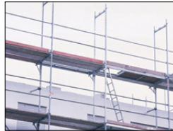
Arbeiten mit Gerüsten
