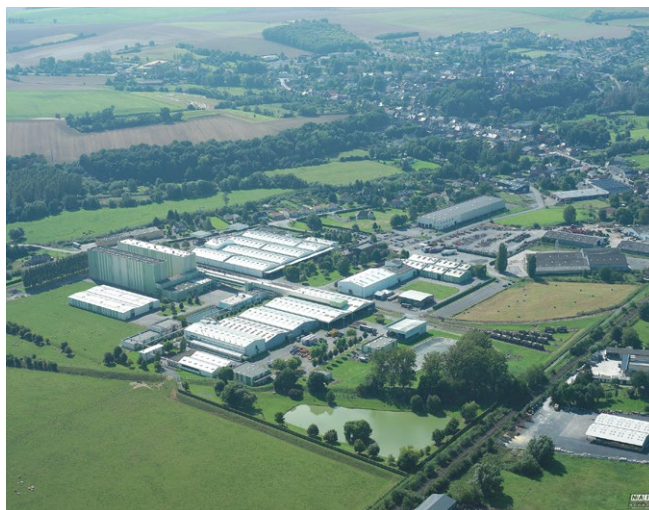
Vue aérienne du site de Marle-sur-Serre
