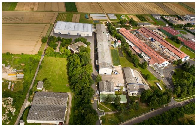
Vue aérienne du site de Méréville
