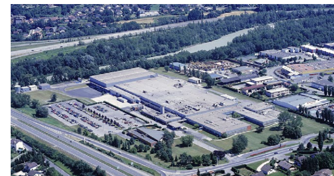
Vue aérienne du site de Gaillard
