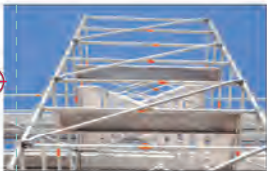
Arbeiten mit Gerüsten
