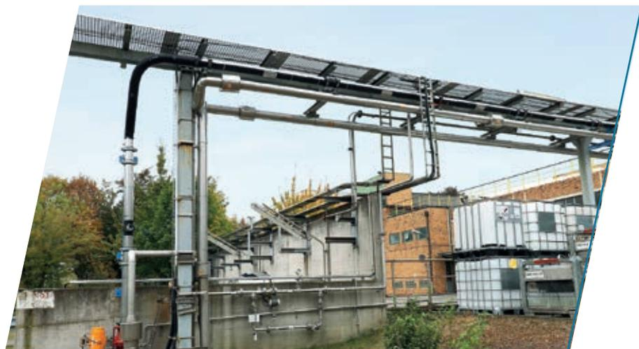
unterdruckfeste Leitung entstanden ist. Diese ist zudem mit speziellen Bögen gesichert, die wie eine Feder wirken. Dehnt sich die schwarze Abwasserleitung bei Sonneneinstrahlung aus, kann sie somit nachgeben ohne dass es zu Verwerfungen kommt, die unerwünschte innere Spannungen bewirken.
